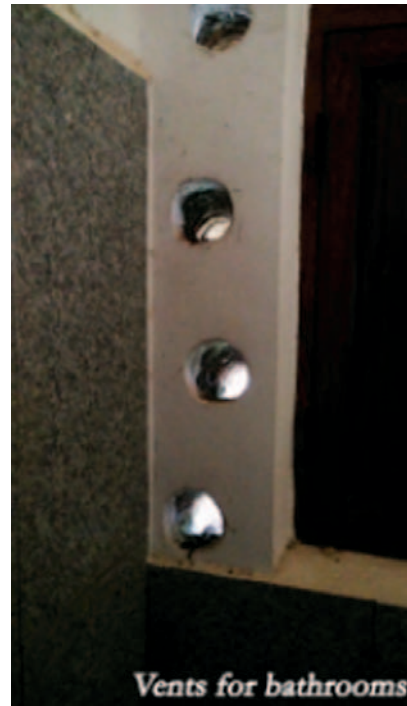
Fig. 24 Wall (bath room)
