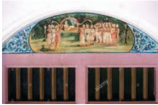
ventilators above the door
