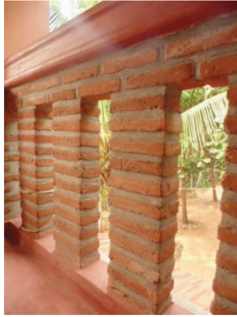
Fig. 21. Parapet wall
